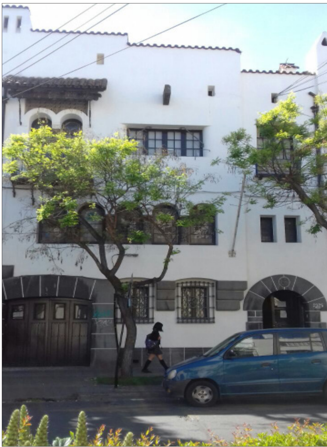
Fachada de una casa construida en las primeras décadas del siglo, hoy ocupada por la Facultad de Medicina de una Universidad del sector.
