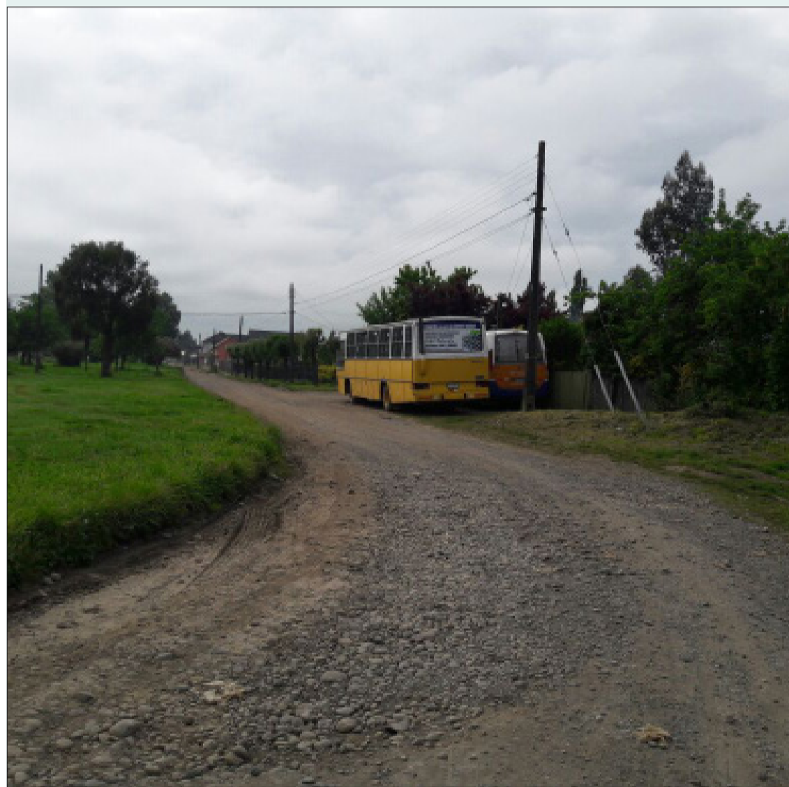
Lectura de la foto: La Avenida Balmaceda de Río Bueno, carece de pavimentación e iluminación, lo cual la vuelve una calle peligrosa, debido a su gran flujo vehicular y peatonal.
