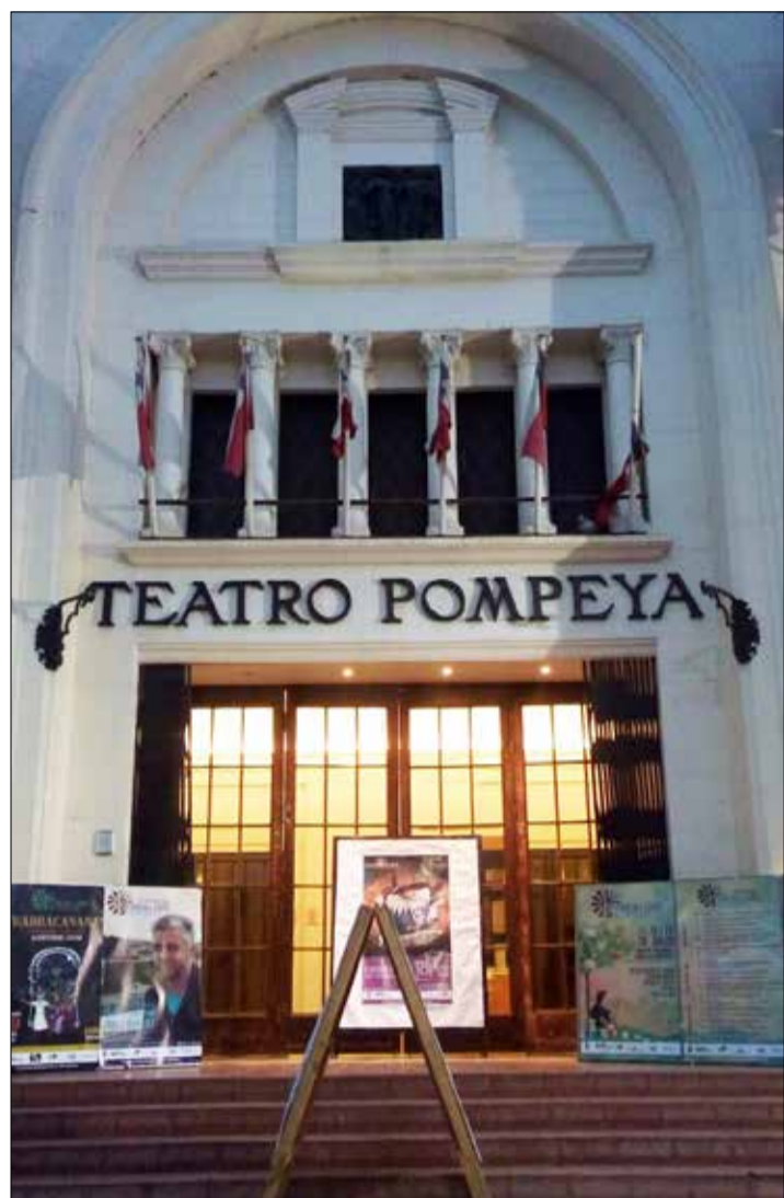
Fachada del teatro en la que se observa su diseño de corte neoclásico.
