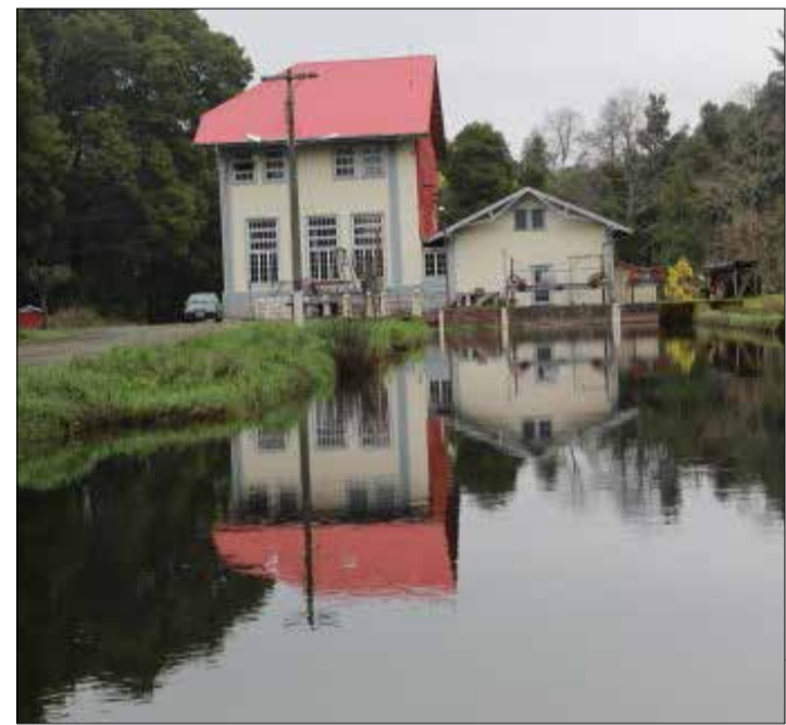
A ORILLAS DEL RÍO LLOLLELHUE, se logra observar la propiedad arquitectónica alemana, en la cual se encuentran las dos turbinas generadoras de energía para el actual molino Kunstmann que produce harina.
